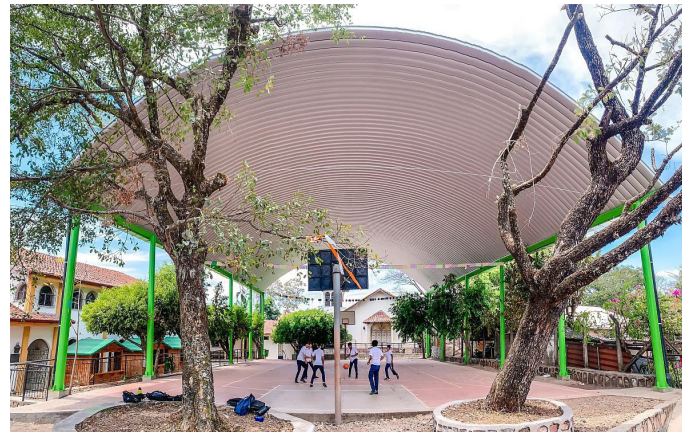
Unser noch intakter, neu überdachter Basketballplatz
