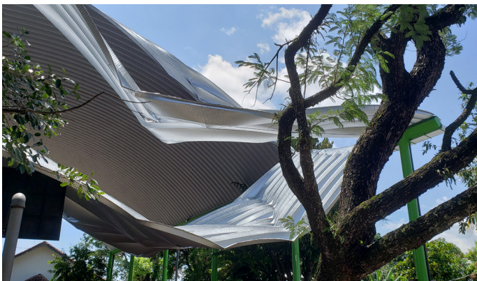
Das vom Sturm beschädigte Dach auf seiner östlichen Seite
