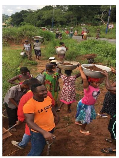
Sand zum Herstellen von Backsteinen muss herantransportiert werden. Das geht hier nicht mit LKW sondern mit Schüsseln und zu Fuß.
